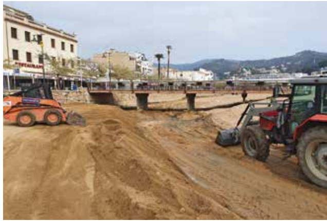
| Treballs amb màquina a l'entorn de la riera. Àrea de Medi Ambient Ajuntament de Tossa de Mar
