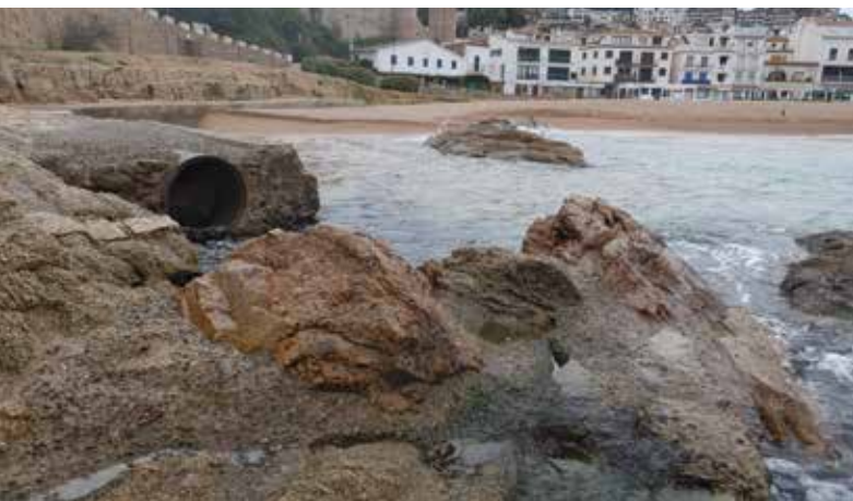
| Col·lector aigües pluvials a es Racó. Àrea de Medi Ambient Ajuntament de Tossa de Mar
