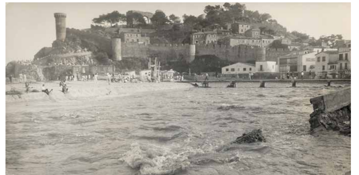
| Rierada de 1959. La força de sa Riera va descalçar el mur del passeig en diferents trams (AMT)
