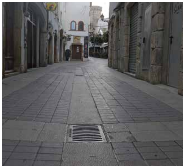
| Embornal de la xarxa de pluvials. Àrea de Medi Ambient Ajuntament de Tossa de Mar
